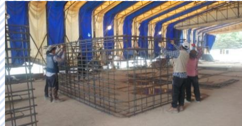
② 철근 조립
