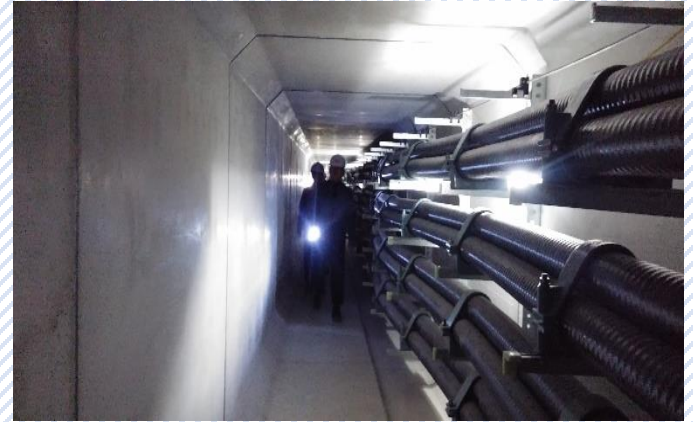
❖ 백석 C/H 전력구 공사
