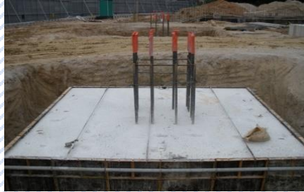
② MAT콘크리트 타설
