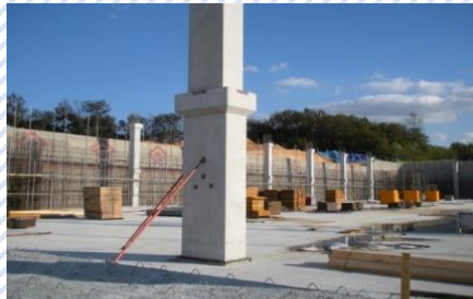
⑥ 기둥 서포트 설치
