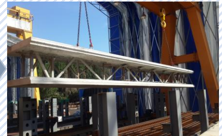
⑧ "B"판넬 콘크리트 타설 /양생 후 탈형
