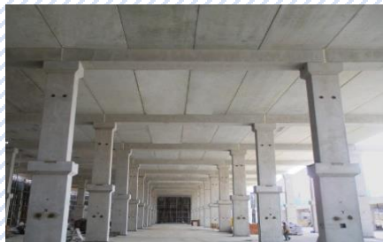
⑩ 하부 조립 전경
