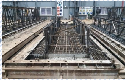
② "A"판넬 철근 및 각관트러스 조립
