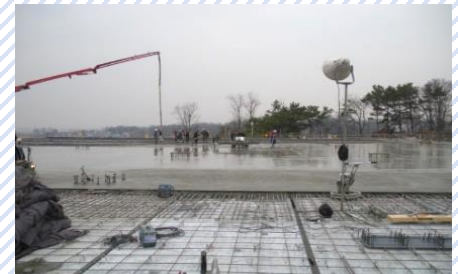
⑫ 토폰 콘크리트 타설
