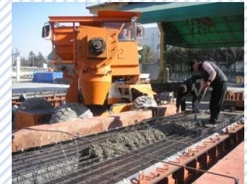
⑩ 콘크리트 타설
