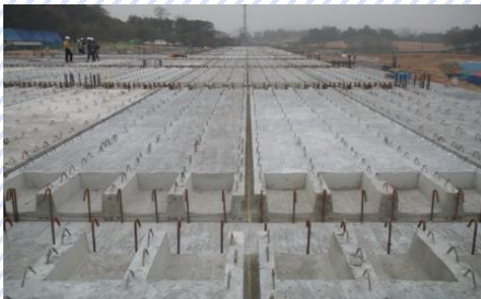
⑨ 상부 조립 전경
