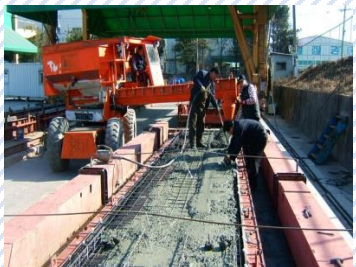
⑪ 콘크리트 다짐
