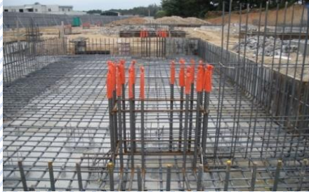
① 앵커프레임 시공
