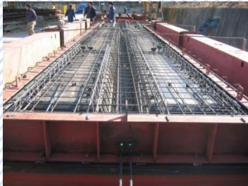
⑥ 철근 배근 완료
