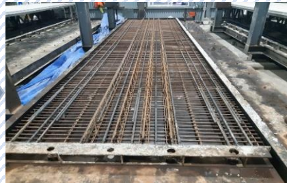
⑥ "B"판넬 철근 조립
