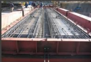
⑥ 철근 배근 완료
