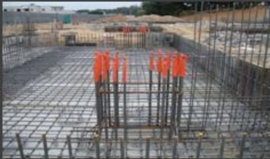
① 앵커프레임 시공
