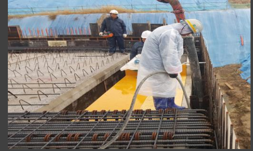
⑥ 콘크리트 타설
