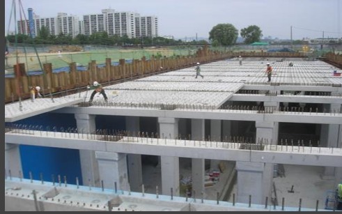
⑤ 부재 설치 및 상부 배근
