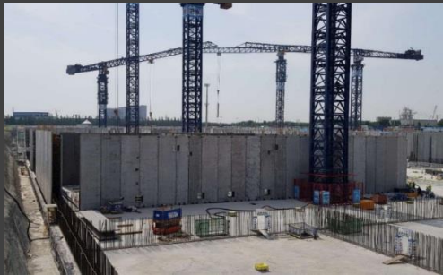
④ 벽체 설치
