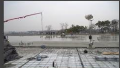
⑫ 토핑 콘크리트 타설
