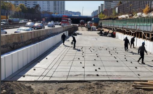
① 버림 콘크리트 타설
