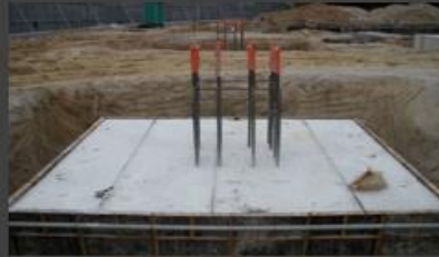
② MAT콘크리트 타설
