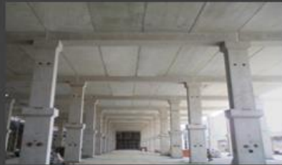
⑩ 하부 조립 전경
