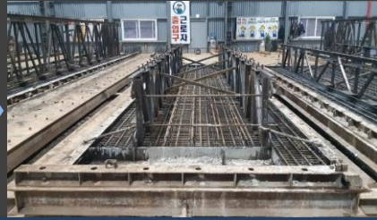
② "A"판넬 철근 및 각관트리스 조립
