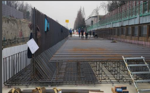
② 기초 및 벽체철근 설치
