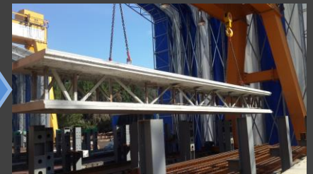
⑧ "B"판넬 콘크리트 타설 /양생 후 탈형
