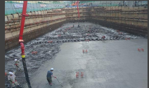
③ 기초콘크리트 타설
