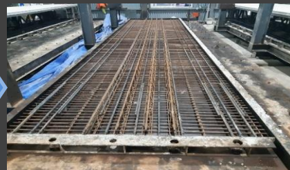
⑥ "B"판넬 철근 조립
