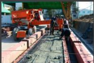
⑪ 콘크리트 다짐
