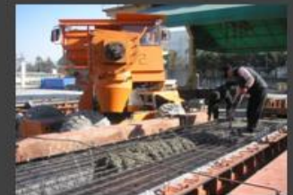
⑩ 콘크리트 타설
