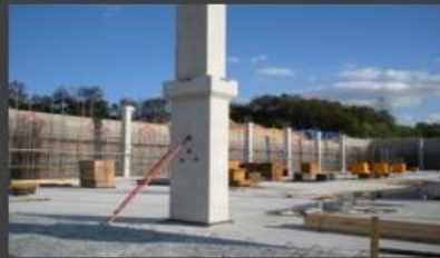
⑥ 기둥 서포트 설치
